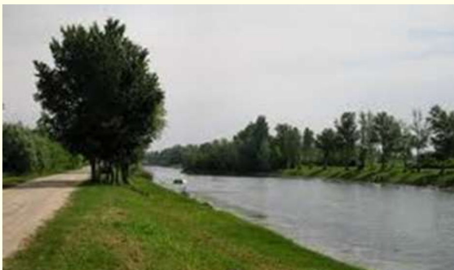
Stato attuale dell'idrovia Padova-Venezia – mare (10 km su 27 scavati)
